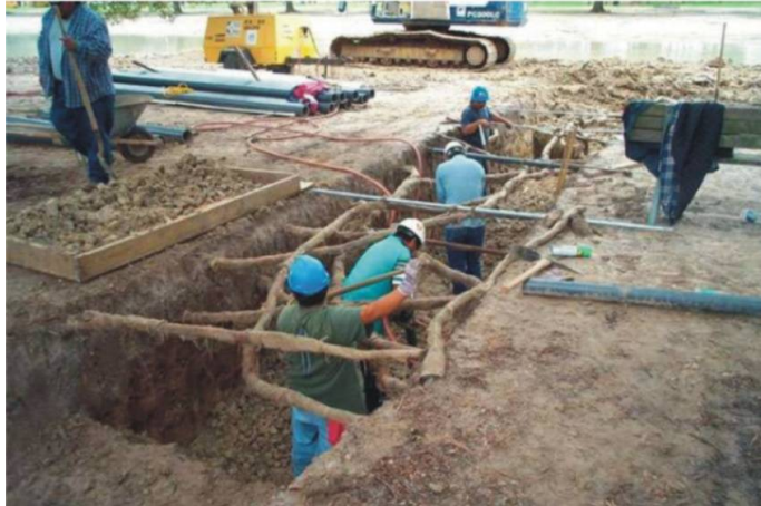
fot. 1. Prowadzenie prac ręcznie w obrębie systemu korzeniowego, Tom Fox, SWA Group.
