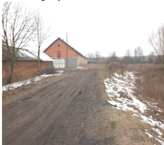
Droga dojazdowa do nieruchomości
