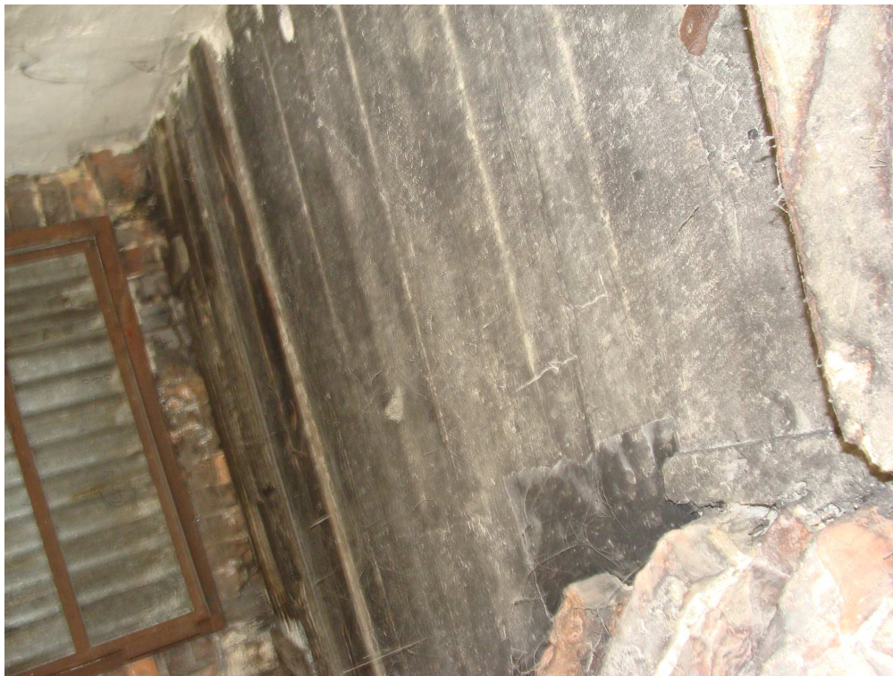
Zdjęcie. 3 – Widok płyty żelbetowej nad tarasem B
