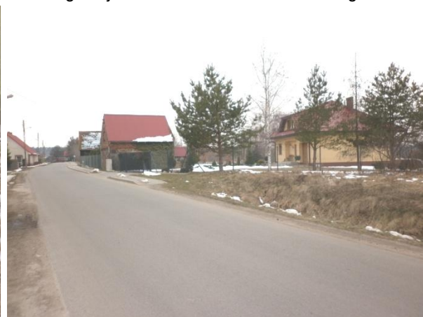
Droga dojazdowa do działki-ul. Piłsudskiego
